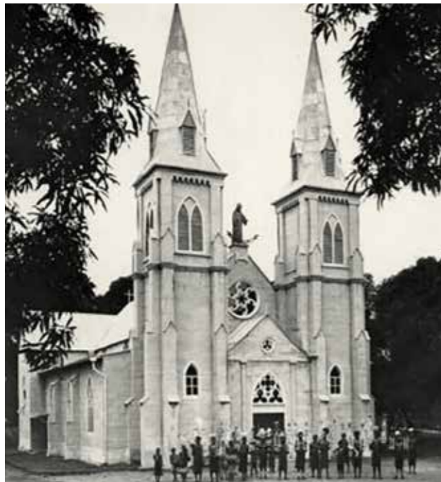
Die Kathedrale des Heiligen Herzens in Vunapope wurde im Februar 1944 bei einem Bombenangriff der Alliierten vollständig zerstört. Quelle: trove.nla.gov.au (Natl. Archive of Australia)
