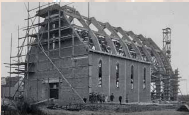
Die für damalige Zeit sehr ausgefallene Zelt-Bauweise mit Rippen aus Stahlbeton konnte nur von der auf Stahlbetonarbeiten spezialisierten Firma Züblin ausgeführt werden. Architekt war Eisenbahnbaurat Eger.
